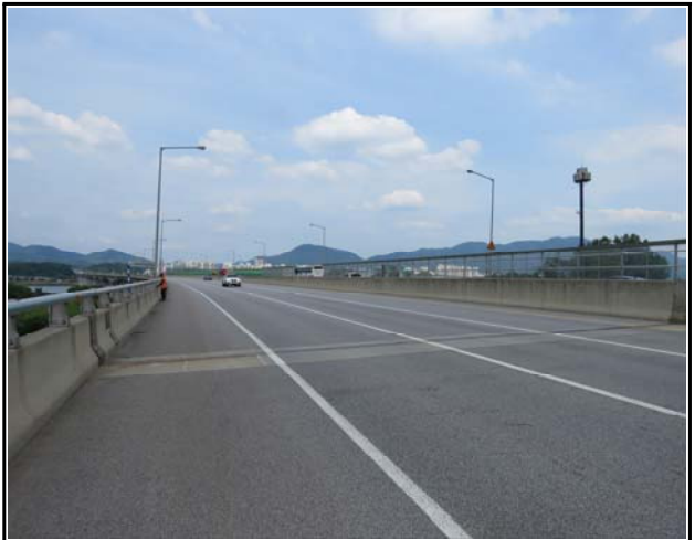
내 용 교면포장 전경
