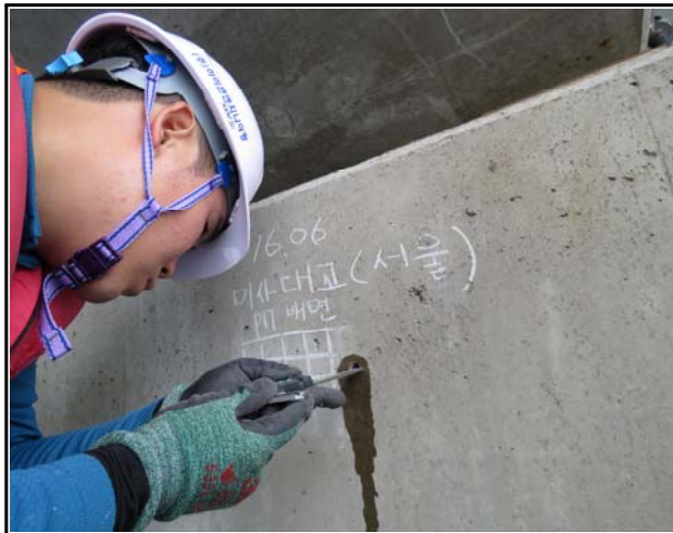
내 용 P7 탄산화 깊이 측정
