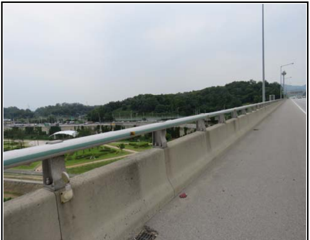
내 용 방호벽 전경
