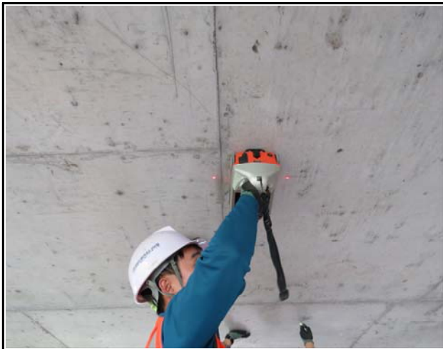
내 용 S1 거더외부 철근 배근 및 피복두께 탐사
