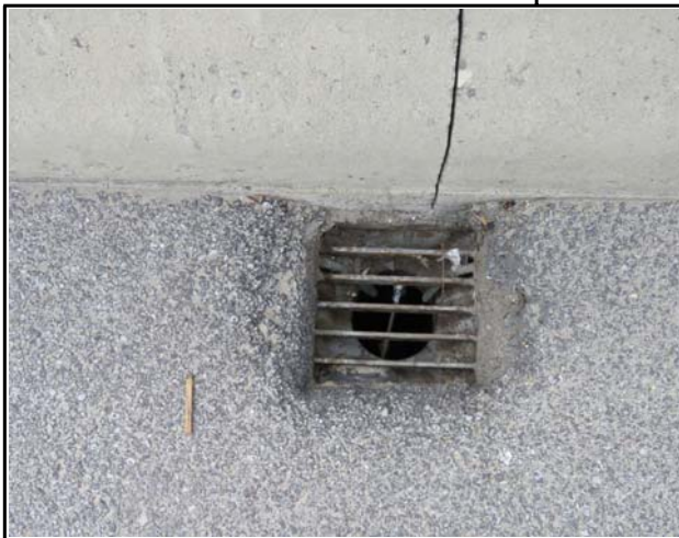
내 용 S3 배수구 상태양호
