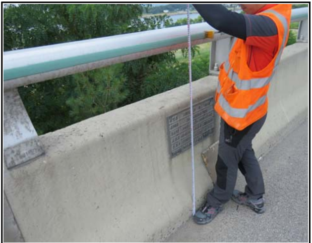
내 용 방호벽 제원조사
