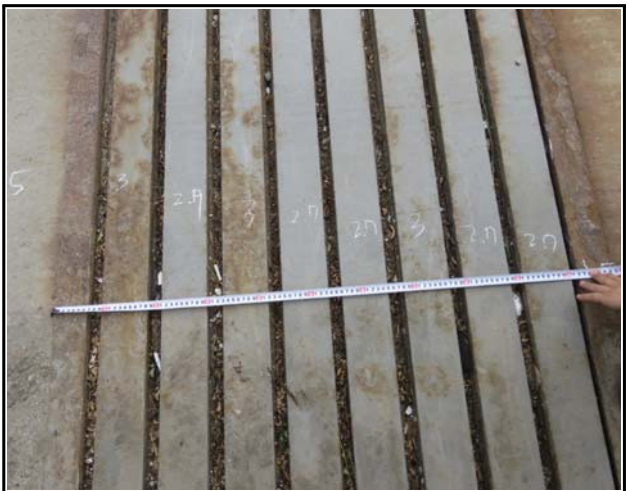
내 용 신축이음 유간조사
