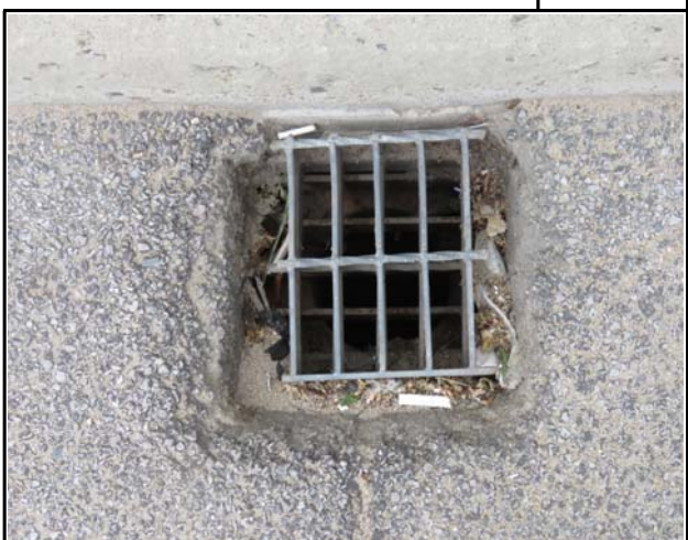
내 용 S15 배수구 상태양호
