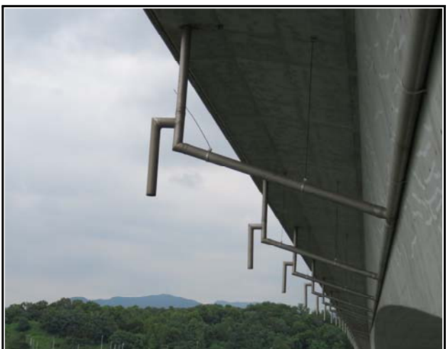
내 용 배수시설 전경
