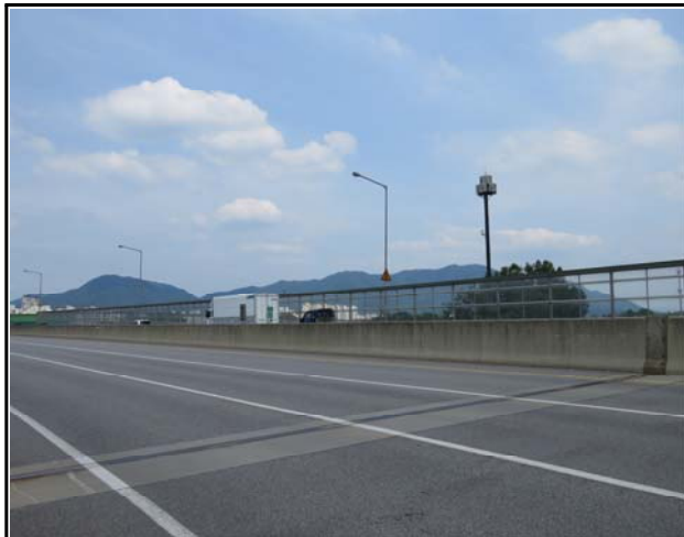
내 용 중앙분리대 전경
